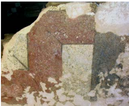
Fig. 155 Detalle do zócolo con imitación de placas mármoreas
