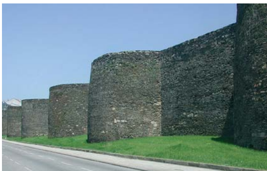
Fig. 7 Vista xeral da muralla romana
