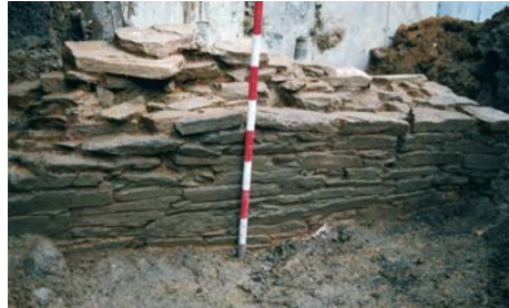
Fig. 30 Muro de lousa
