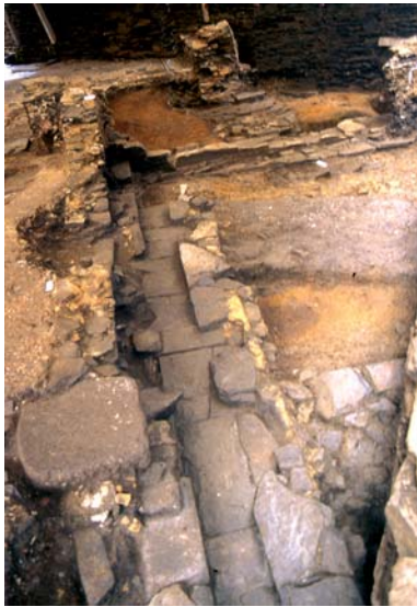
Fig. 67 Canle interior do patio norte
